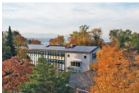
Solarstrom vom Erlenbacher Schulhaus
