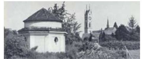
Grundwasserpumpwerk Heslibach, erstellt 1922, heute unterirdisch und nur noch als Notversorgung
