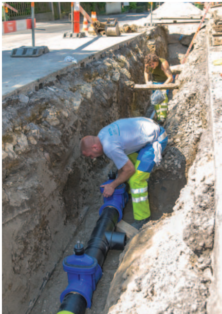
Baustelle Oberwachtstrasse, Küsnacht
